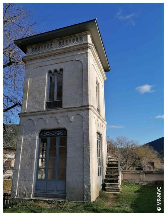
Dans les années 2000, le salon de thé était recouvert d'une toiture terrasse ouverte. Lors des travaux de réaménagement du site Maison Rouge, on a choisi de reconstruire le toit d'origine à quatre pentes coiffées d'un épi central de zinc, encore en place vers 1900. Le bâtiment dispose d'un escalier qui commence au rez-de-chaussée côté sud et qui mène à l'étage côté est. L'entrée de la cave se situe au niveau de la façade nord.
