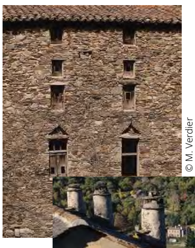
Les baies au dimensions réduites et les nombreuses souches de cheminées sont caractéristiques des magnaneries.
