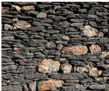
Appareillage en pierre sèche (schiste).
