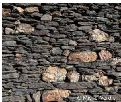
Appareillage en pierre sèche (schiste).
